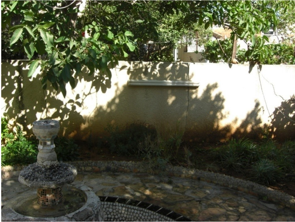
شكل (6-20) : صورة توضح الجدار المستحدث الذي يشطر حديقة آل بعاره إلى قسمين، المصدر : الباحث.
