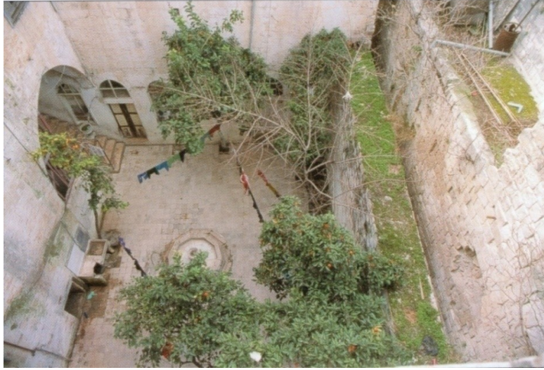
شكل (4-6): صورة داخل فناء منزل نمر النابلسي ، المصدر : ( روفو، 2002، ص: 30)
