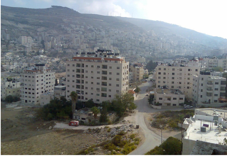
شكل (6-23) : صورة توضح مجموعة من المباني الحديثة والارتفاعات والارتدادات المستخدمة، المصدر : الباحث.
